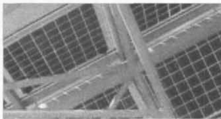
图5 斜顶建筑上天窗、采光顶式应用
