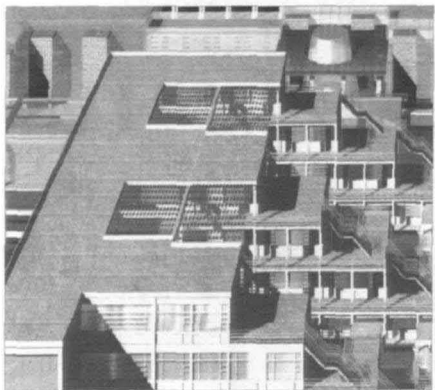
图8 平顶建筑上天窗、采光顶式应用
