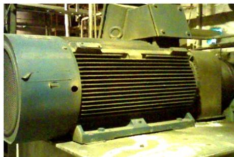
散热不良导致电机外壳温度异常
