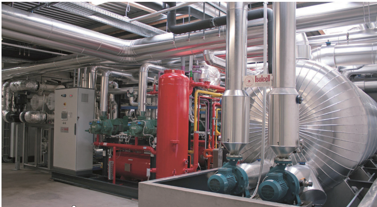
德国 Mittelbaden 水果批发市场的能源控制中心。在贝加莱的积极支持下, aeteba 公司开发了一个模块化、扩展型控制解决方案, 它可以将所有能源供应系统结合起来。
