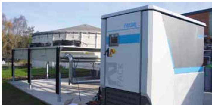
■ 利用废气和发动机冷却液余热发电的 ePack 余热发电系统额定输出功率为 20 千瓦。
